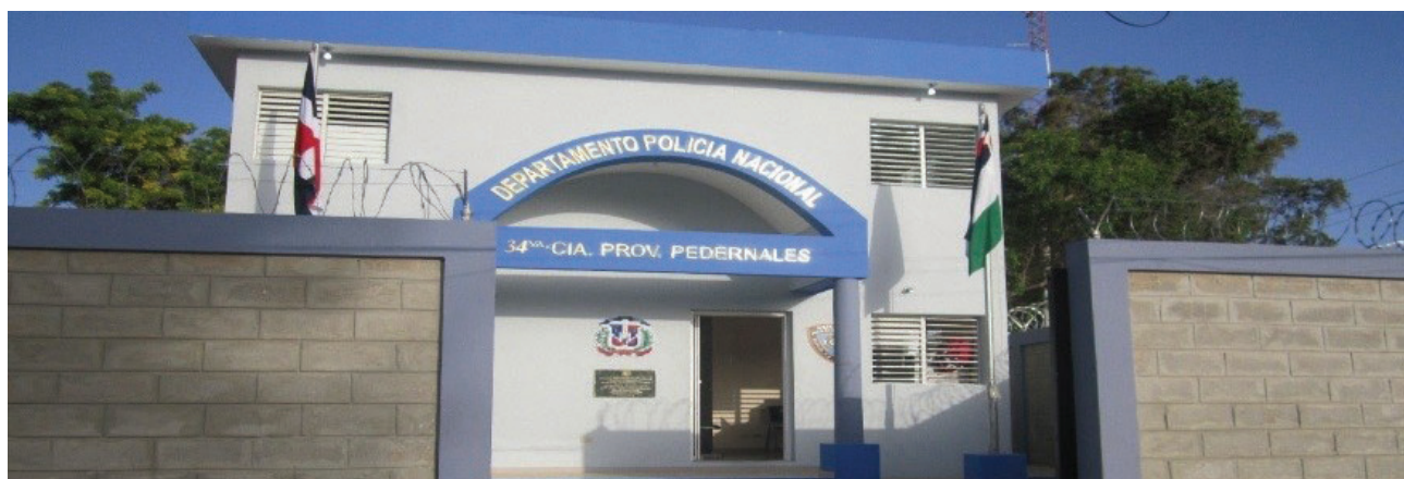
Cuartel General de Pedernales, se observa remodelación destacamento.
